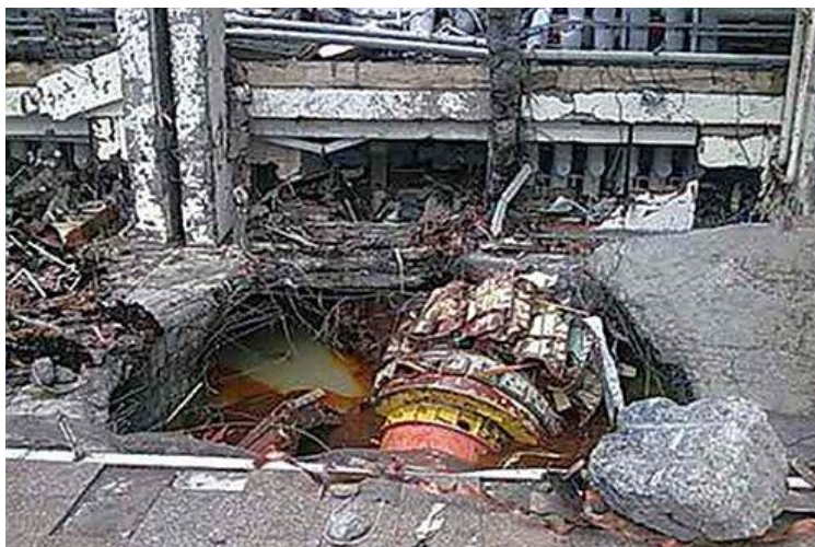
Рис. 6 – ГА-2 после аварии ( http://bigpicture.ru/?p=4962 )
