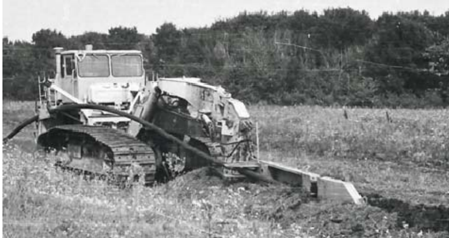
Рис. 4 – Укладання поліетиленового газопроводу \varnothing 160\text{мм} ножовим трубозаглиблювачем на базі уніфікованого шасі УШ-16
