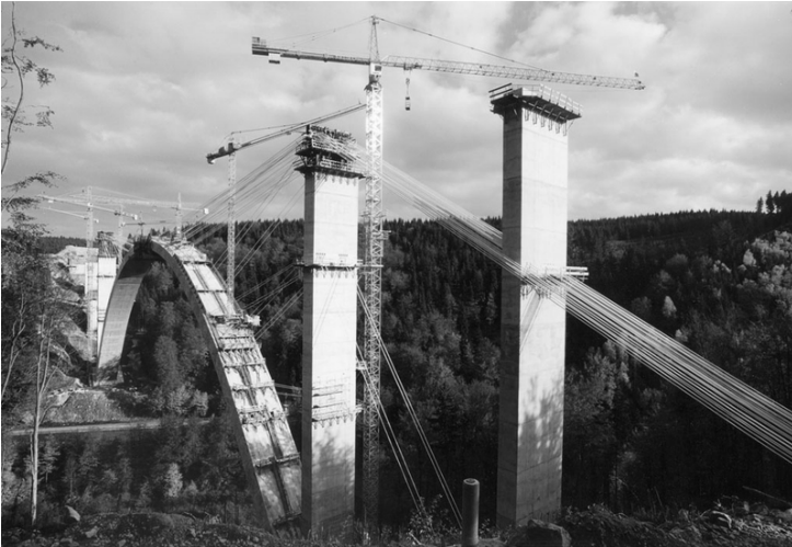
Рис. 6 – Строительство моста через реку Вильде-Гера, Германия
