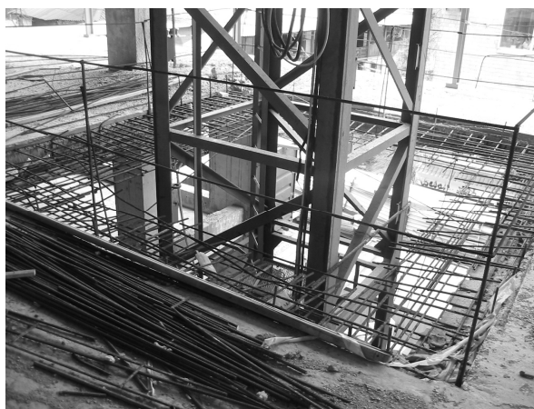
Рис. 3 – Комбинированная установка приставных башенных кранов, г. Харьков, 2015 г.
