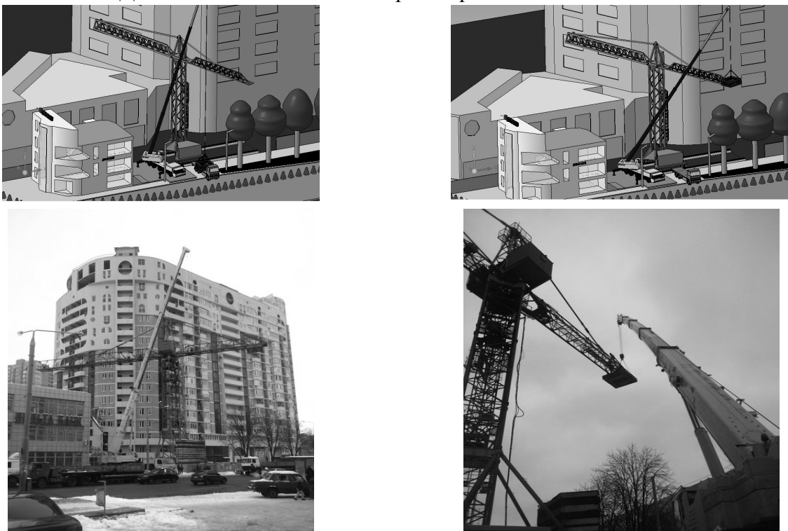
Рис. 11 – Демонтаж відкидної секції та подвижного противовеса башенного крана КБ-674
