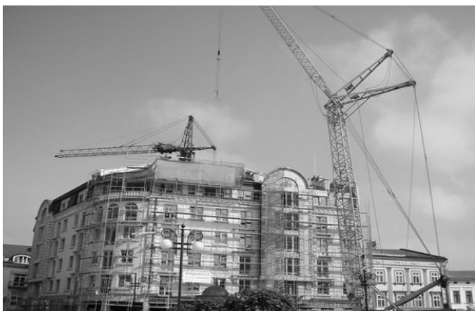
Рис. 2 – Демонтаж «замурованного» башенного крана при строительстве жилого дома, г. Ивано-Франковск, 2006 г.
