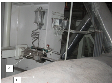
Рис. 5. Опора демпфіруюча гідравлічна: 1 – трубопровід; 2 - опора
